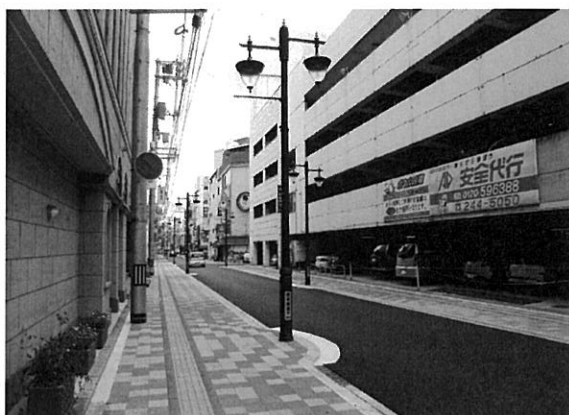
薬研堀通りの歩車道整備
