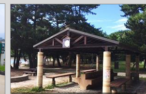
(8) レクリエーションエリア 小戸公園(福岡市)の屋根付き水場施設
