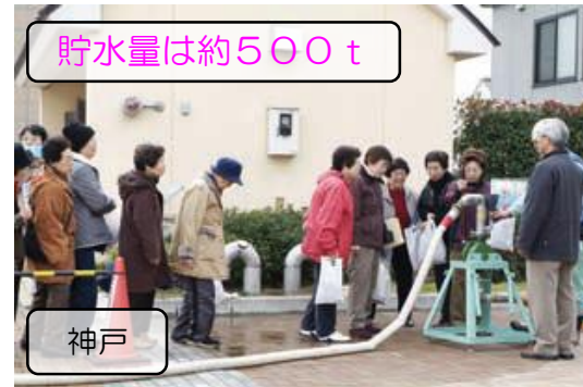
耐震性貯水槽
