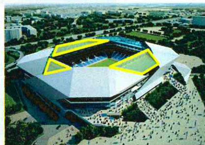
太陽光発電設置場所
