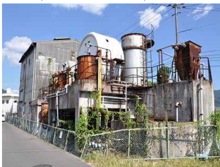
船越焼却場 (平成22年9月17日撮影)
