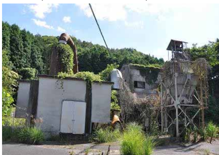
瀬野焼却場 (平成22年9月17日撮影)
