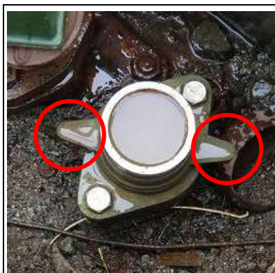
④金具が上下に作動するか確認する。
