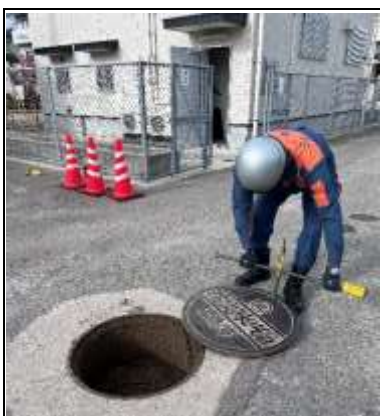
④防火水槽の蓋をスピンドルバルブで開放する。（詳細は水利部署要領参照）
