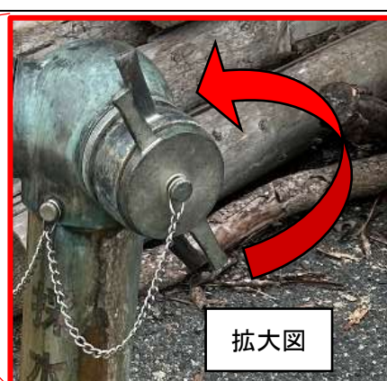
※採水口のキャップはチェーンと取っ手がある。(ねじ式の蓋)
