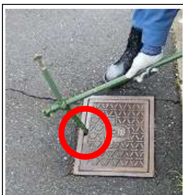
②差し込み口を確認し、手前に引くように持ち上げる。
