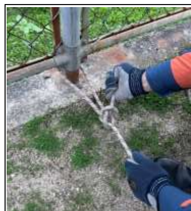
⑥吸管控え綱を強固なものに結索する。
