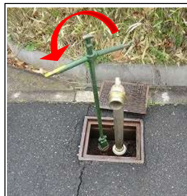
⑥スタンドパイプの横にスピンドルバルブを差し込み、反時計回りに回すと吐水する。
