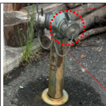
①採水口側のキャップ（ねじ式）を左に回して外す。
