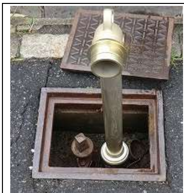
⑤スタンドパイプを金具に押し込み、結合する。 ※抜けないか必ず確認する。
