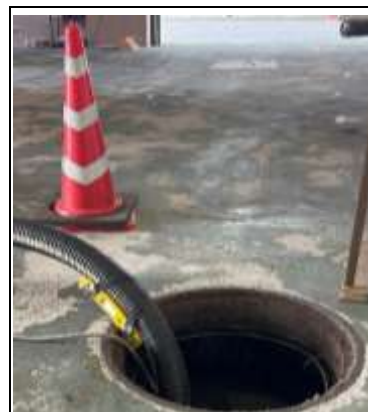
⑨揚水した後、放水を開始したら、枕木及びカラーコーンを設置する。
