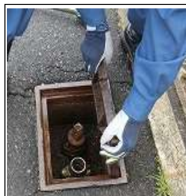
③蓋を持ち上げ、足の上に蓋を落とさないようにゆっくり地面に倒す。
