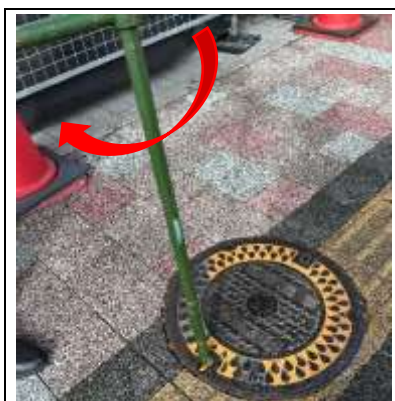
⑤黄色の○印及び先端が内側を向くようにスピンドルバルブを90度回転させる。
