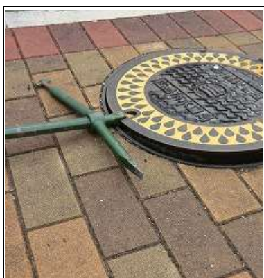
⑦スピンドルバルブを地面に付けると蓋が持ち上がる。
