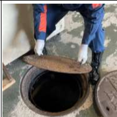
⑧蓋は全部取り外す。
