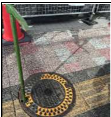
④差し込み口にスピンドルバルブを垂直に立てる。
