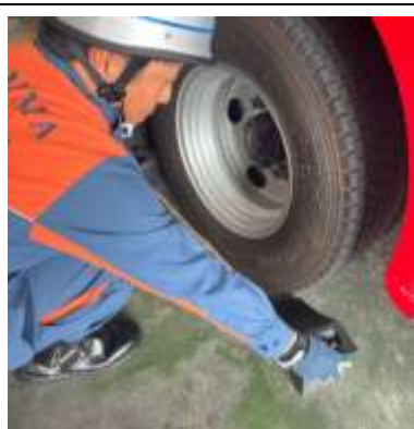
②ポンプ車に車輪止めを設定す。
