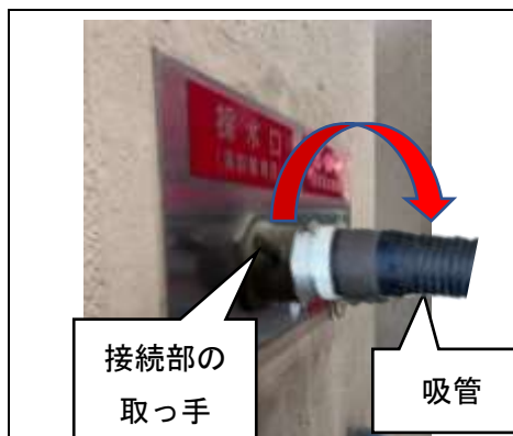
②吸管を一人が水平に保持し、もう一人が採水口の接続部を時計回りに回して接続する。
