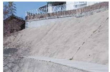
モルタル・コンクリート吹付工
