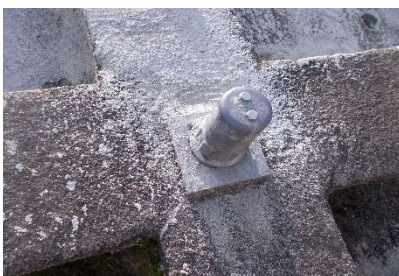
アースアンカー工
