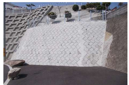
崩壊した崖の本復旧工
