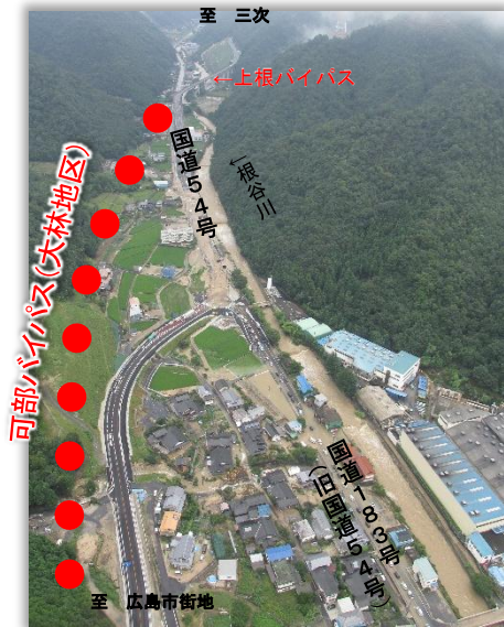
写真：平成26年8月20日豪雨災害時の国道54号の（下浜ヶ谷交差点付近）浸水状況
