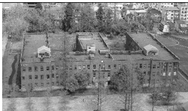
現在の広島大学旧理学部 1 号館
