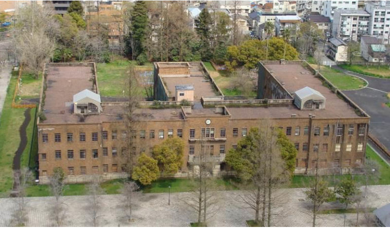
現在の広島大学旧理学部 1 号館
