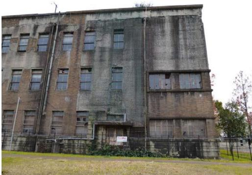
外壁タイルの剥落（左側側面）
