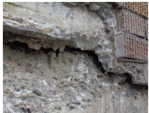
外壁タイルとコンクリートの剥落
