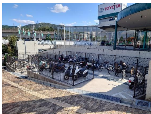
〔広域公園前駅駐輪場(R2 完成)〕
