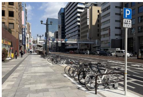
〔民間路上駐輪場(国道 54 号) (R6 完成)〕
