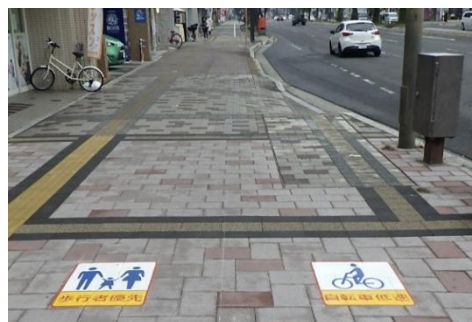
〔ピクトグラムの設置〕
