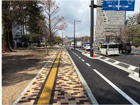
〔自転車道(中区)(R6 整備)〕
