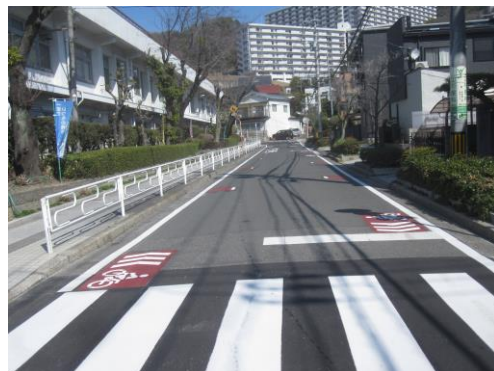
〔尾長小学校地区(ゾーン30プラス*の一環)(R6 整備)〕
