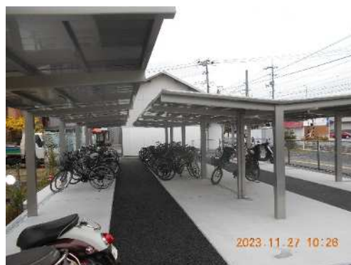
[梅林駅駐輪場（屋根新設）]
