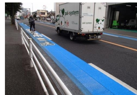
<自転車専用通行帯の例(埼玉県さいたま市)>
