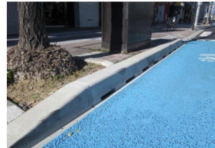
<自転車の走行性に配慮した排水構造の例(広島県福山市)>
