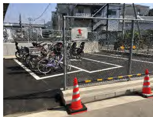
写真 天神川駅北第二 (R2 完成)
