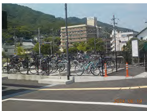
写真 安芸中野駅 (R3 完成)
