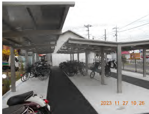
写真 梅林駅 (R5 屋根新設)
