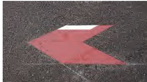
写真 矢羽根型路面標示への白線設置
