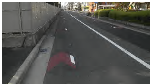
写真 矢羽根型路面標示への白線設置
