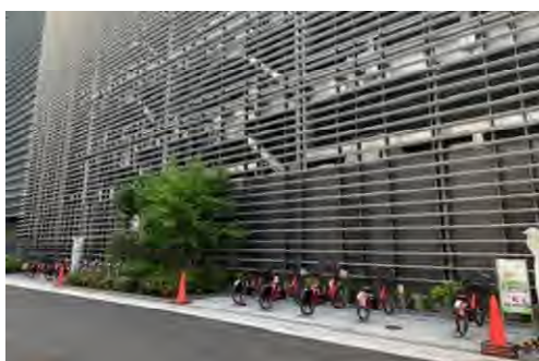
写真 商業施設へのポート設置
