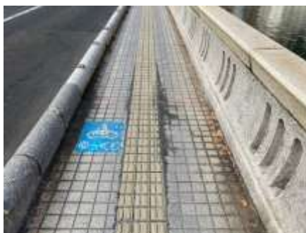
《整備状況（緑大橋）》
