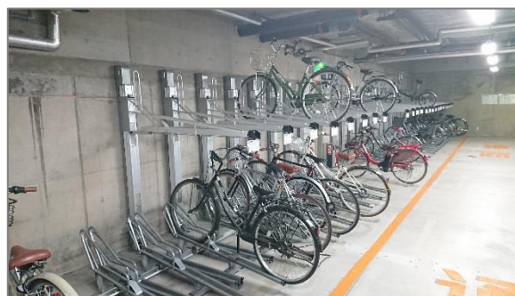
〔垂直式二段ラックの事例(パセーラ駐輪場)〕
