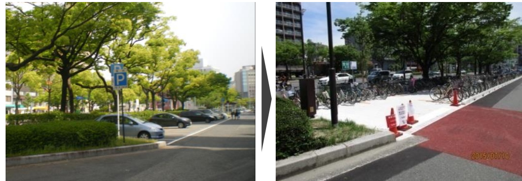
〔駐車場から駐輪場への転用(稲荷町)(H27 完成)〕
