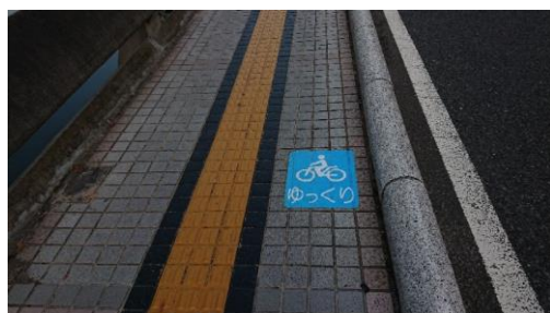
〔自転車の減速を促す路面標示の設置 (平和大橋歩道橋)〕
