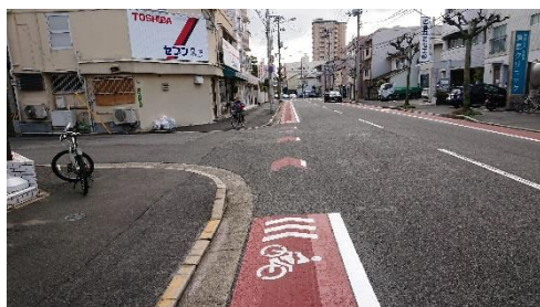
〔矢羽根型路面標示への白線設置〕
