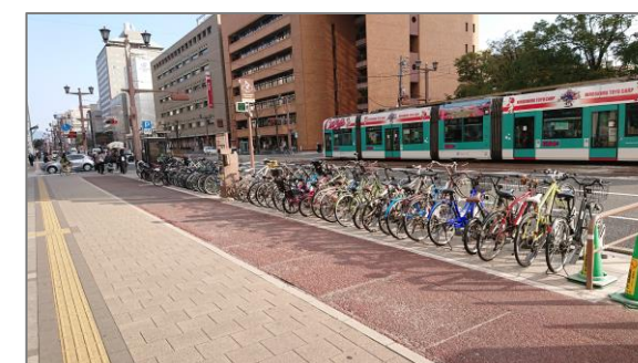
〔国道 54 号(H29 整備)〕
