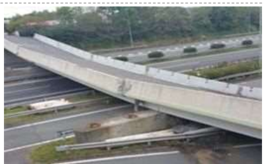
平成28年熊本地震における 九州自動車道を跨ぐ府領第一橋の落橋 〔引用：国土交通省 HP（道路における震災対策） https://www.mlit.go.jp/road/bosai/measures/index1.html 〕
