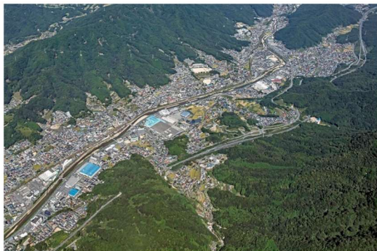
一般国道2号(現道, 東広島バイパス)
