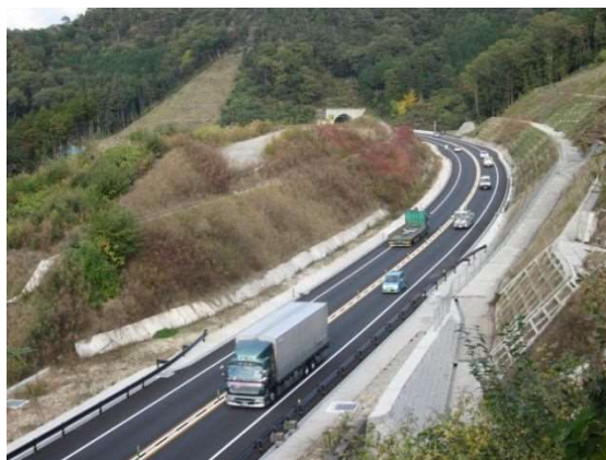
一般国道 2 号 東広島バイパスの様子 〔写真提供：国土交通省 広島国道事務所〕
