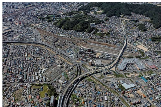
広島高速道路 1号線, 2号線, 5号線(建設中)
