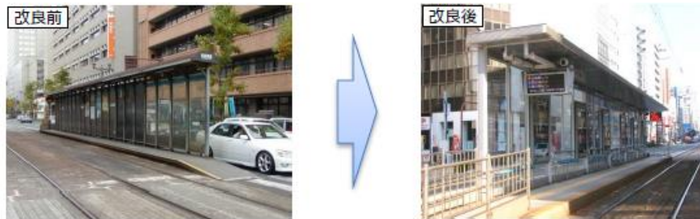
図表2-1-⑬ 電停施設等の改良
