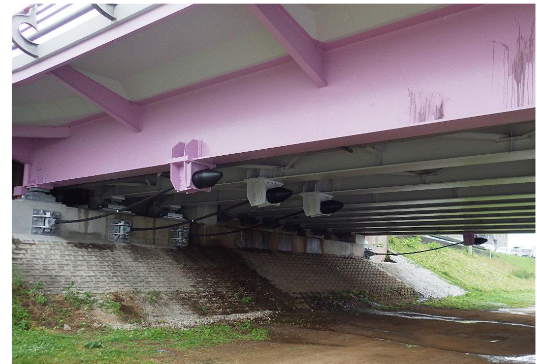
図表2-1-⑱ 橋りょうの耐震化（新己斐橋 落橋防止装置の設置）
