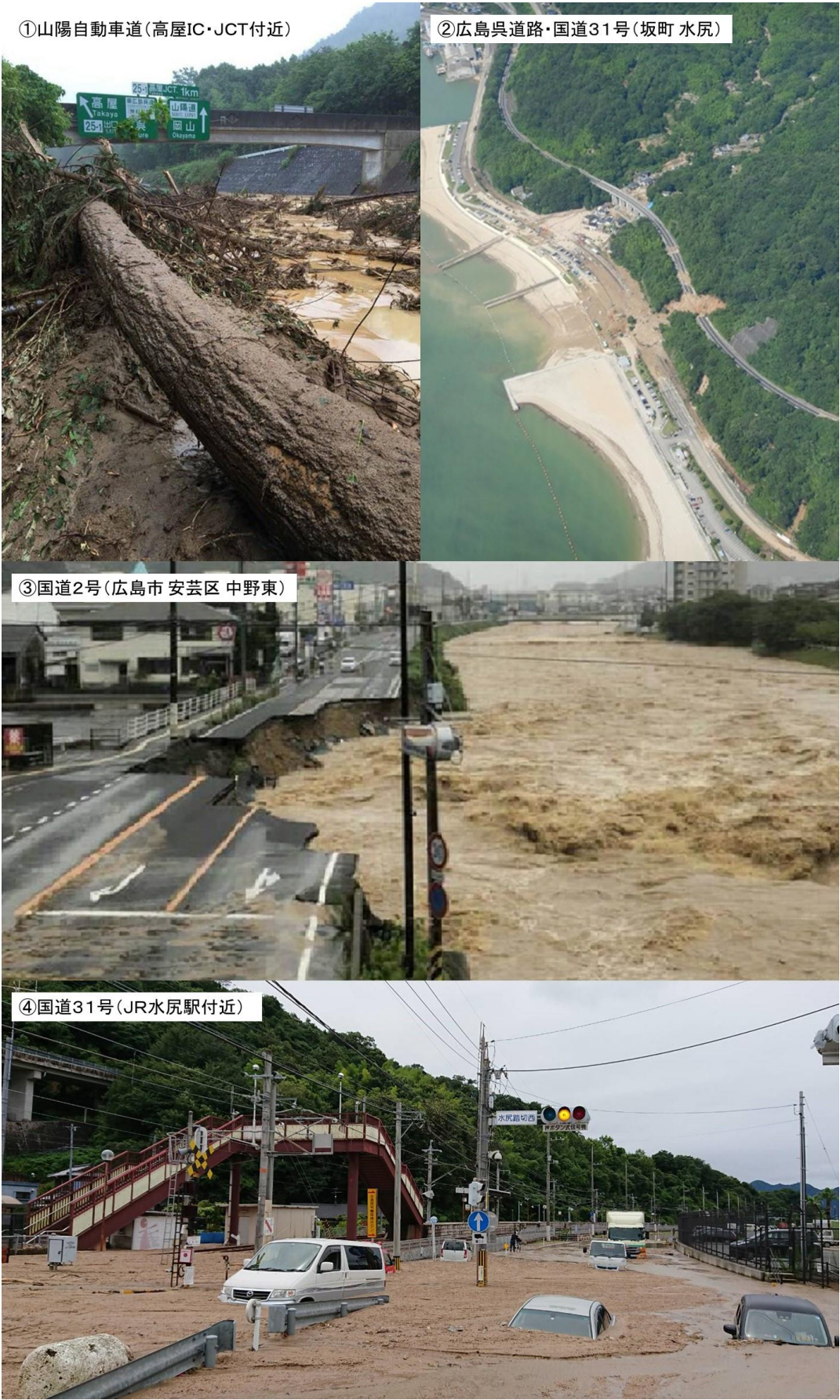
図表1ー⑯ 平成30年7月豪雨災害の被害概況写真
