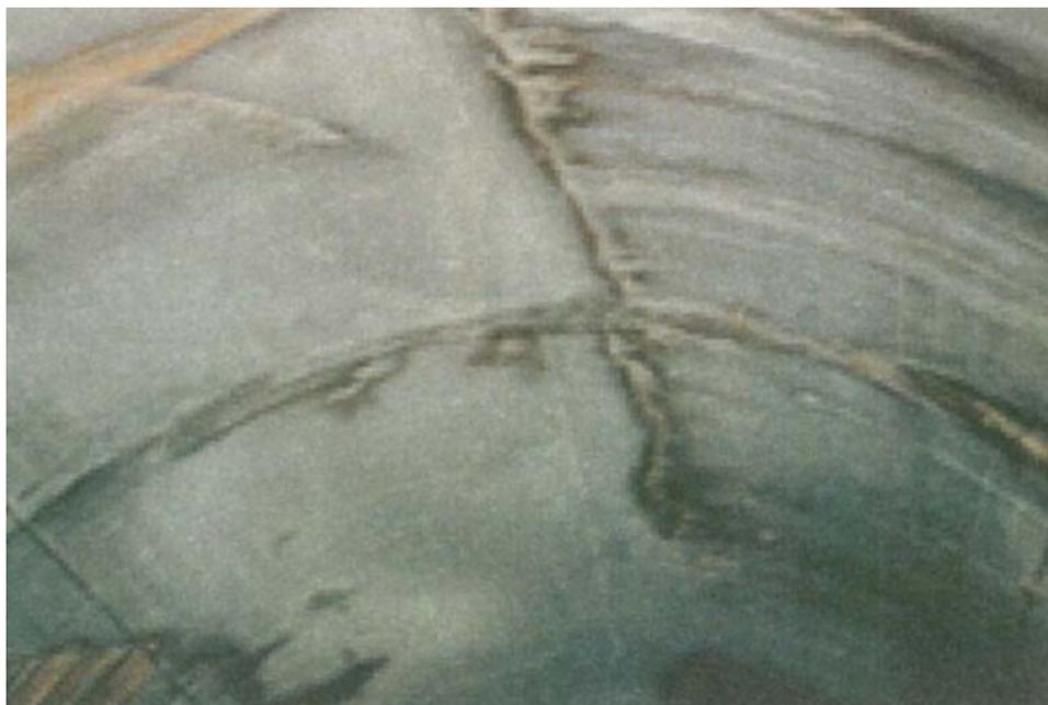
付写真 覆工の天端付近に発生した縦断方向のひび割れの例
