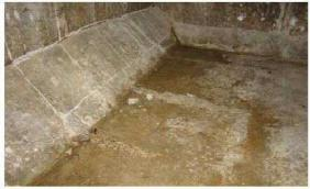
箱桁内部などの部材内部に、滞 水が生じている状態.
