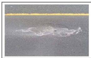
舗装表面に特異な損傷が見られ る場合、床版が著しく損傷して いることもある.
