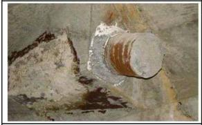
桁内のPC鋼材定着部に錆汁や石 灰分の滲出がみられる例
