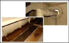
箱桁内部などの部材内部に、滞 水が生じている状態.
