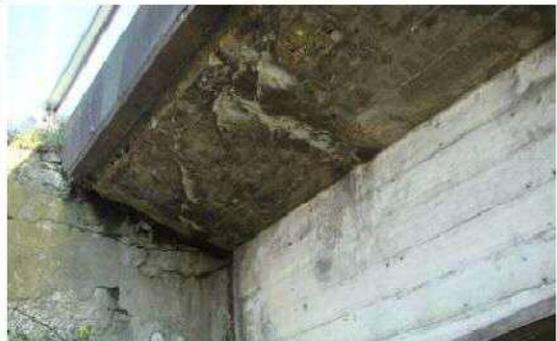
例 床版内部への雨水の侵入が顕著に生じており、放置すると急速に劣化が進むと見込まれる場合
