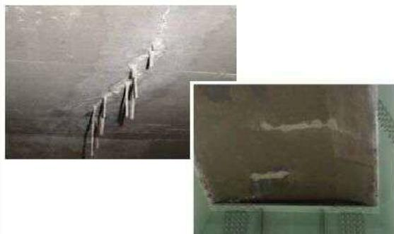
例 ひびわれは比較的少ないものの、明らかな貫通ひび割れ（漏水、石灰分の析出）がある場合
