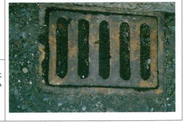
メモ 排水ますが土砂に より目詰まりしてい る。
