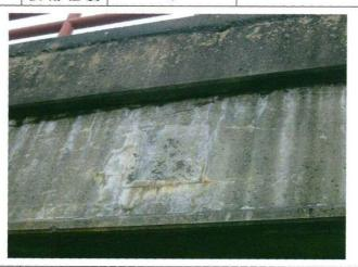
写真番号 18-3 損傷の種類 18 定着部の異常 分類2:PC鋼材横締め 部 材 名 主 桁 損傷程度 e
