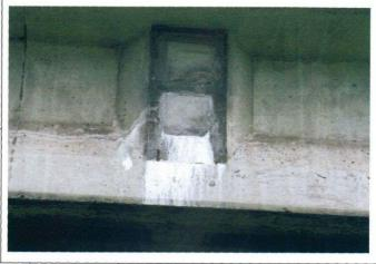
写真番号18-2損傷の種類18 定着部の異常分類2:PC鋼材横締め部 材 名主 桁損傷程度c
