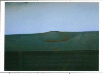
写真番号23-2損傷の種類23 変形・欠損部 材 名主 桁損傷程度c
