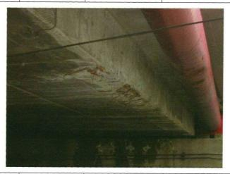
写真番号②3-3損傷の種類②3 変形・欠損部 材 名伸縮装置損 傷 程 度c
