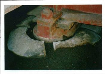
メモ 沓座モルタルが著 しく欠損している。
