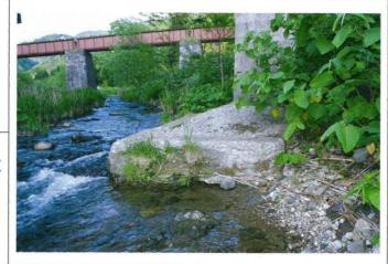
メモ 流水のため著しく 洗掘されている。
