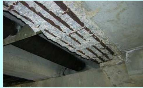
主桁の鉄筋露出
