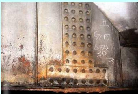
主桁の腐食
