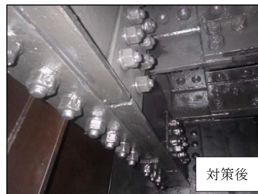
写真 3 当て板補強の対策状況
