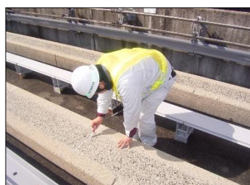
軌道内近接目視点検
