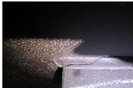
写真 1 鋼製橋脚内部梁上フランジの塗膜割れ (近接目視のみでは鋼材の亀裂が検出できない)
