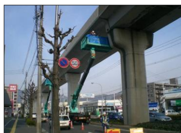
軌道外点検状況
