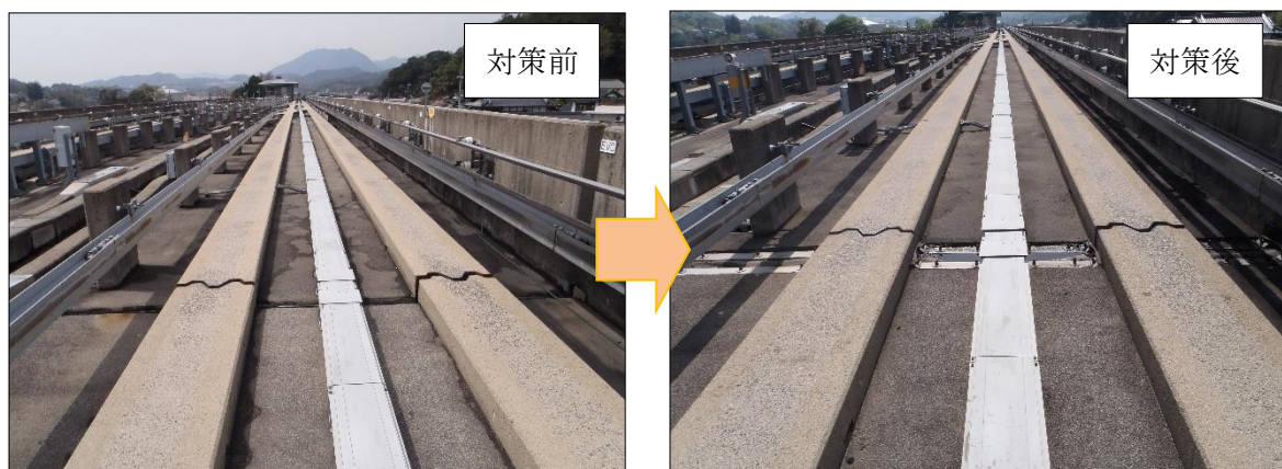
図－1.3.12 伸縮装置の取換え
