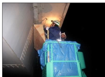
バケット式(ブーム長 27m)作業状況
