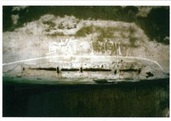
メモ RC主桁の鉄筋が 露出しており、鉄筋 の腐食が著しい。
