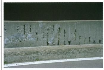
メモ RC製高欄の鉄筋 が露出しており、鉄 筋の腐食が著しい。
