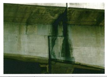
写真番号 ⑥-5 損傷の種類 ⑥ ひびわれ ひびわれ幅:大 部 材 名 主 桁 損傷程度 d(損傷パターン①) ひびわれ間隔:小
