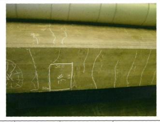
写真番号⑥-8損傷の種類⑥ ひびわれひびわれ幅:大部 材 名主 桁損傷程度e(パターン①)ひびわれ間隔:大
