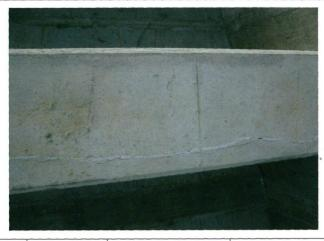
写真番号 ⑥-2 損傷の種類 ⑥ ひびわれ ひびわれ幅:大 部 材 名 主 桁 損傷程度 d(損傷パターン②) ひびわれ間隔:小
