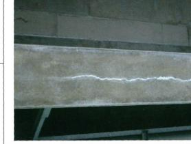
メモ PC主桁にひびわ れ幅 0.2mm の縦方 向のひびわれが 1 本発生している。
