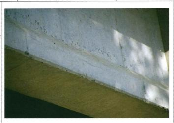
写真番号 6-6 損傷の種類 6 ひびわれ ひびわれ幅:大 部 材 名 主 桁 損傷程度 d(損傷パターン⑩) ひびわれ間隔:小
