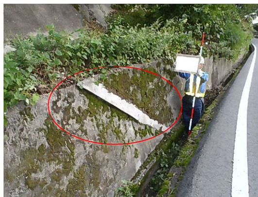
写真では亀裂補修後もせり出しが進展している
