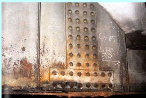
主桁の腐食
