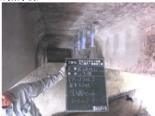
ひび割れ注入
