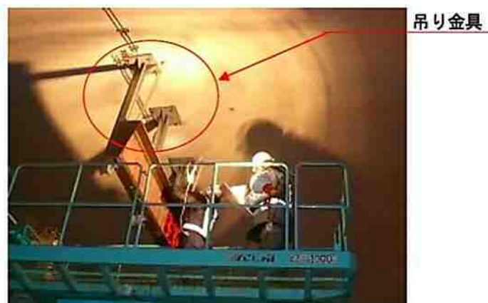
付写真 触診作業状況
