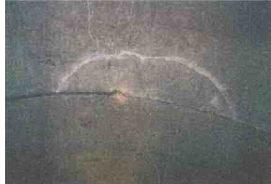
付写真 横断方向目地の天端付近に発生した半月状のひび割れの例
