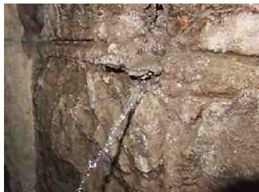
付写真 漏水（噴出）している例
