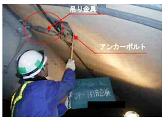
付写真 打音検査作業状況
