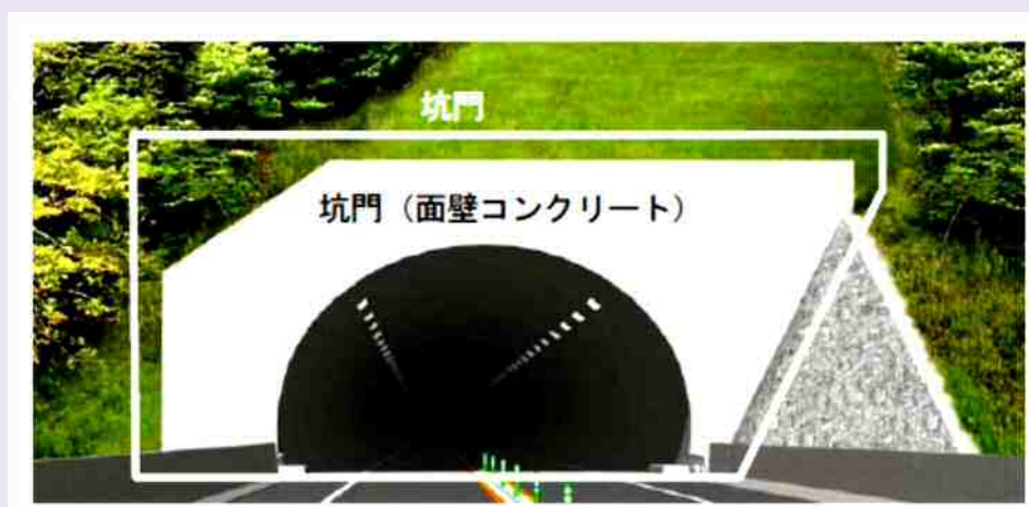
図-4.2 点検対象箇所（トンネル坑口部）
