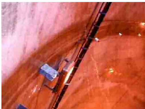
付写真 漏水（噴出）している例
