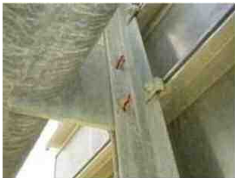
標識板取付部
