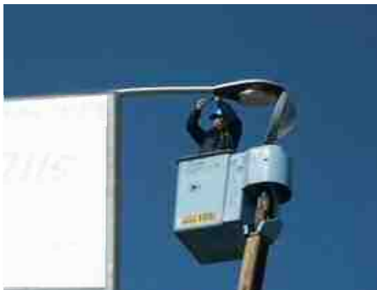
写真 8-10 高所作業車を使用したランプ交換作業
