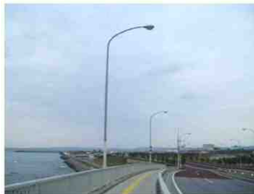
海岸付近に設置
