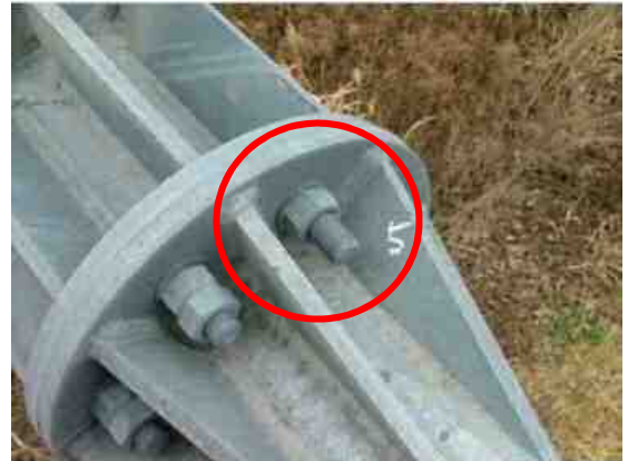
写真 8-9 設置後 10 年以内の附属物の変状事例
