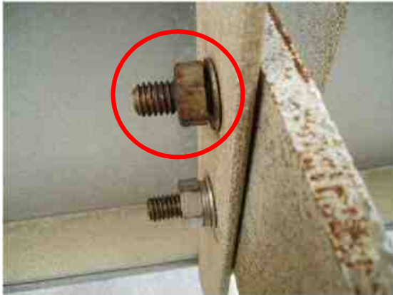
写真 8-9 設置後 10 年以内の附属物の変状事例
