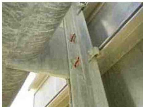
標識板取付部
