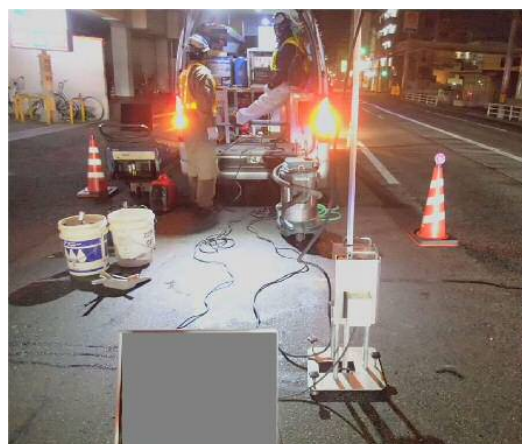
＜写真 5.2-3＞スコープ調査状況
