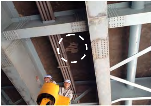
写真(左) コンクリート片剥離箇所、写真(右)落下したコンクリート片 (平成25年5月7日)
