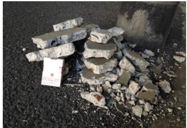
写真(左) コンクリート片剥離箇所、写真(右)落下したコンクリート片 (平成25年5月7日)
