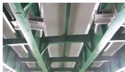
【床版の補修状況】
