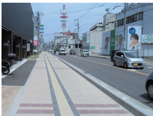
▲交通安全施設の整備 (歩道整備)
