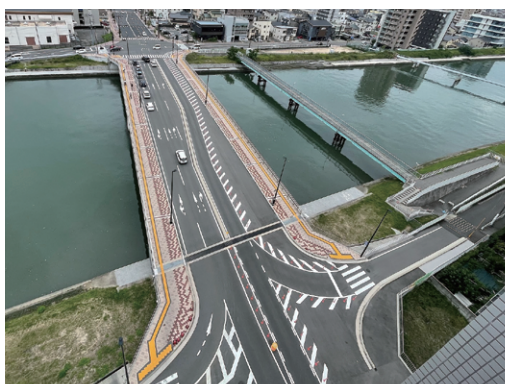
▲道路・街路の整備 (東雲大州線 東大橋の整備)
