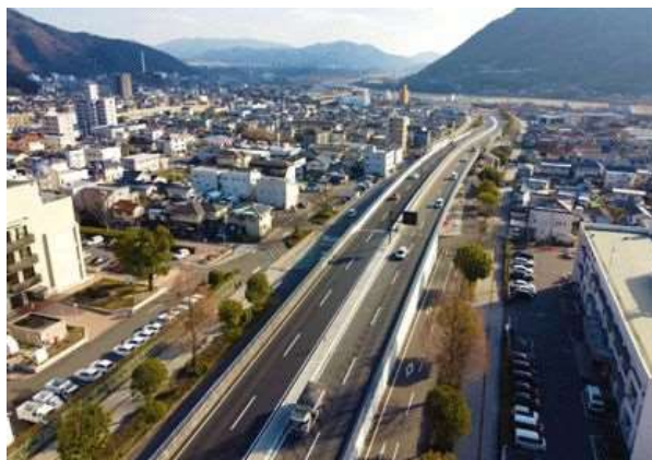
一般国道 54 号 可部バイパスの様子 〔写真提供：国土交通省 広島国道事務所〕
