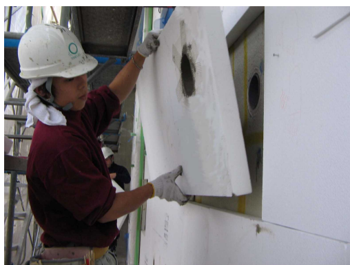
【 外断熱工法の工事状況（南区字品東） 】
