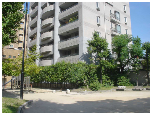
【 緑化による目隠し（中区上櫛町） 】
