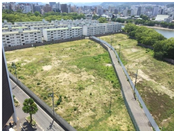
いちぶ ざんていせいび けんえいもとまちじゅうたくあとち 一部をオープンスペースとして暫定整備する県営基町住宅跡地
