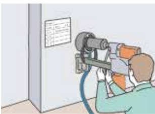
コンクリートコア抜き調査
