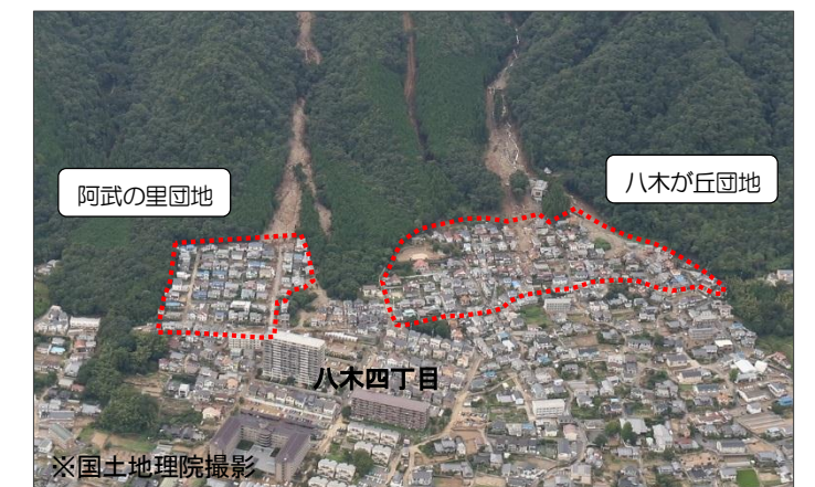
安佐南区八木地区の住宅団地の被災状況
