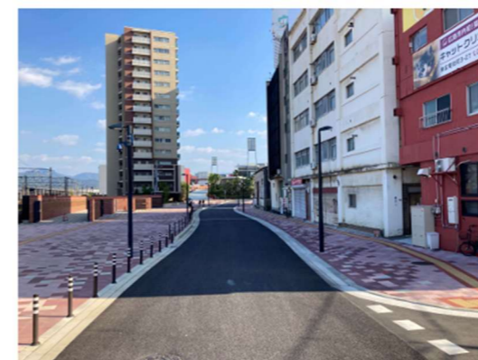
マツダスタジアムへの歩行者用道路整備
