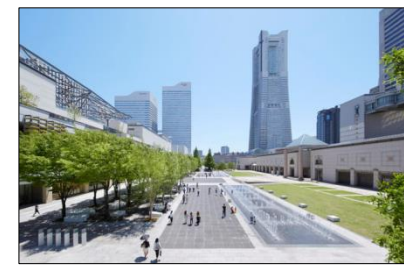
グランモール公園 (横浜市) ・舗装の下に雨水貯 留機能を設け、植 栽への水の供給と ヒートアイランド現 象の緩和を図る公 園を整備
