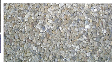
↑ 車道部舗装：脱色アスファルト舗装
