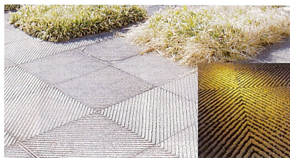
↑歩道部舗装：コンクリートブロック
